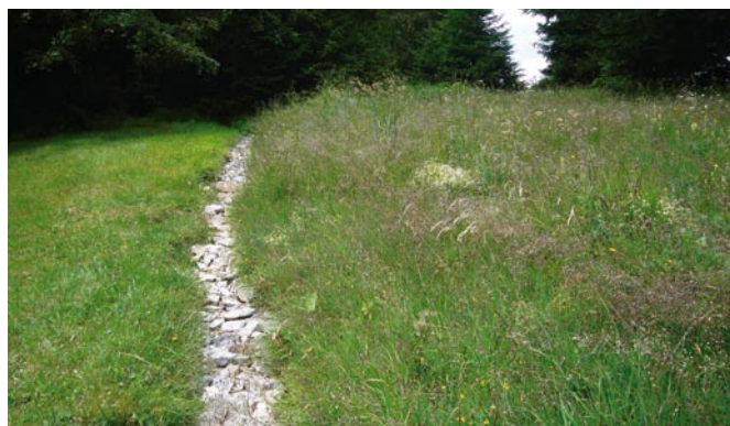
Fig. 86 > Canaletto di drenaggio riempito di sassi
